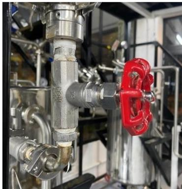
**Nota.** En la figura 36 se evidencia la fotografía que representa las válvulas de globo instaladas en los equipos del CEPIIS.
