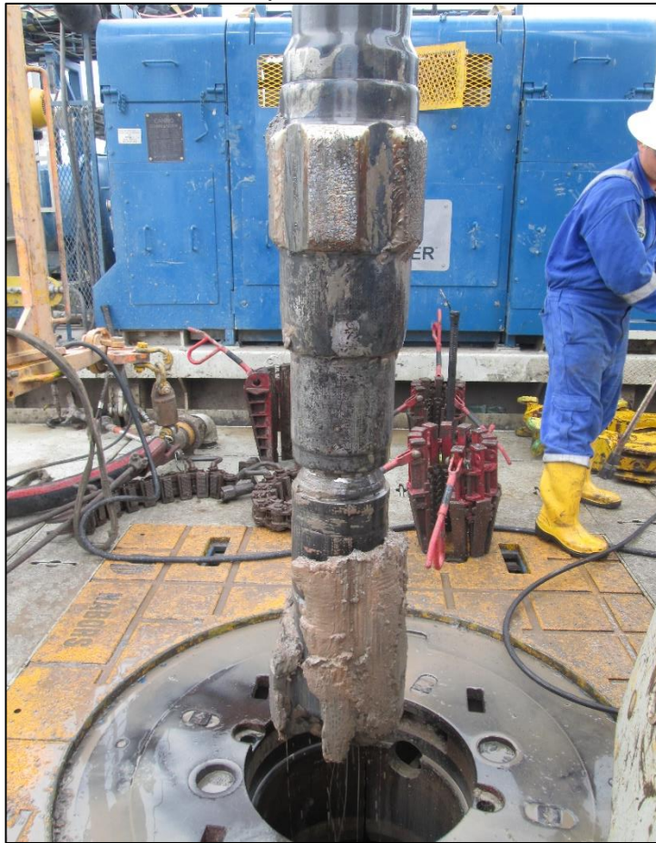
Figura 46. Salida de la broca en el pozo CA236 al alcanzar la formación objetivo.
