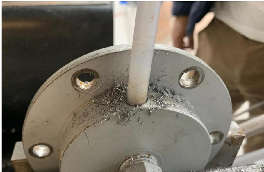
**Nota.** En la imagen se está comprobando que una manguera de 5/16" entre de manera justa en el agujero recién realizado en el extremo inferior de una de las tapas que cubre el haz de tubos del intercambiador de calor.
