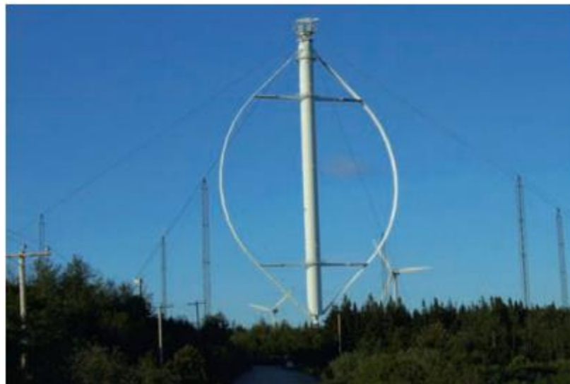
Aerogenerador de eje vertical tipo Darrieus
