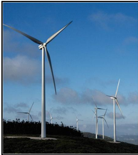
Figura 2. Turbina eólica de vertical modelo Vestas.
