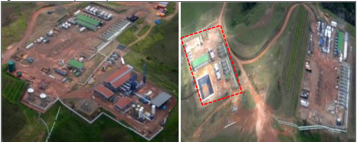
Figura 13. PAD's de inyección 5 y 6.
